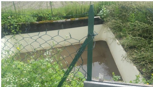
Photo n° 8 : le bassin tampon existant (en cours de réfection)
